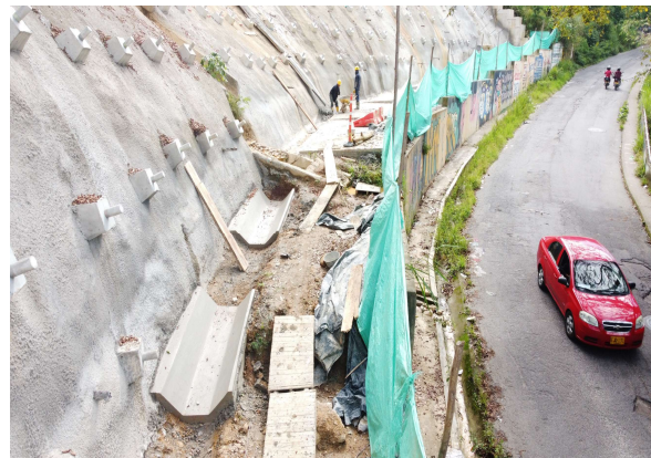
Registro Fotográfico 5. Fundida de Cunetas Terraza Inferior Santa Helena
