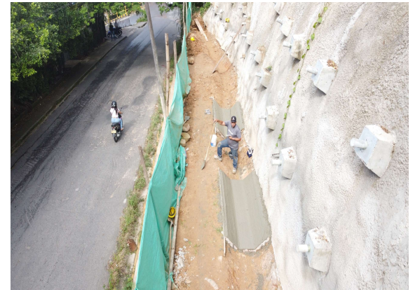
Registro Fotográfico 6. Fundida de Cunetas Terraza Inferior Santa Helena
