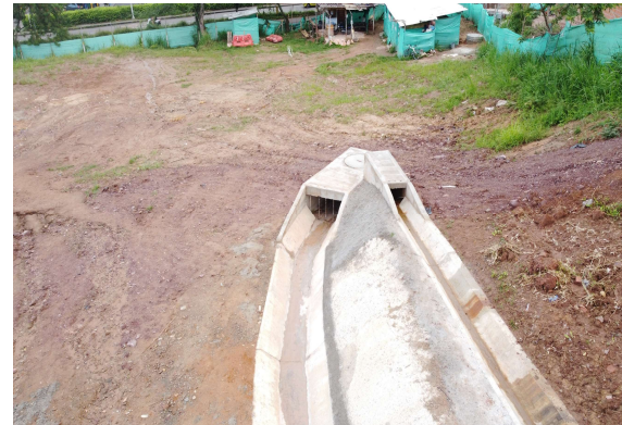
Registro Fotográfico 6. Entrada a la Caja de Inspeccion del Sector Talud Calle 128 con Transversal del Oriente.
