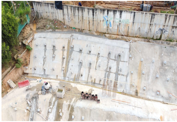
Registro Fotográfico 5. Fundida de Cunetas Terraza Inferior Santa Helena
